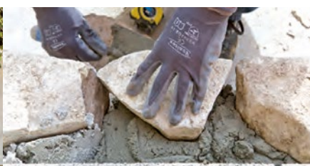
MAÇONNERIE DE PIERRES
