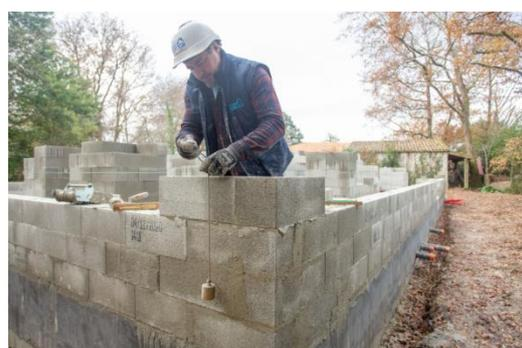
Les blocs Airium™ utilisés pour les murs structurels permettent une meilleure isolation thermique et acoustique de la maison, tout en la rendant plus saine et plus économe en émissions CO<sub>2</sub> : **-25% par rapport à une maçonnerie courante.**
